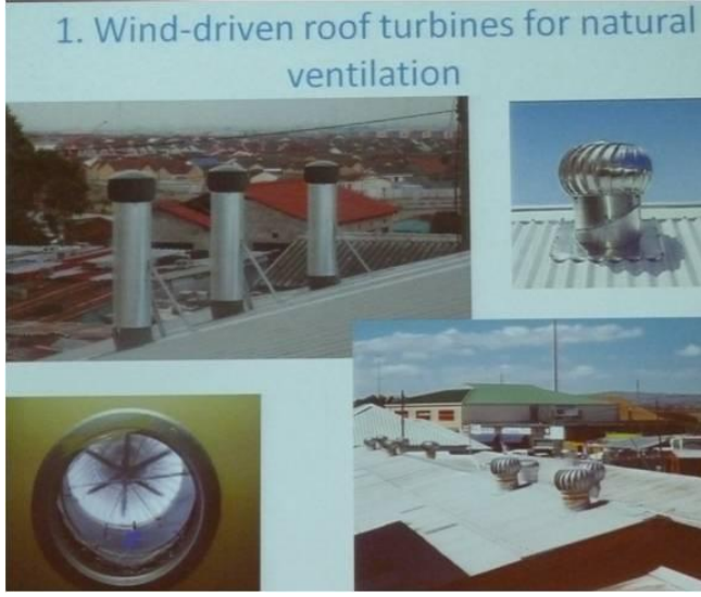
Resim. Çatıya konulan rüzgar türbini
