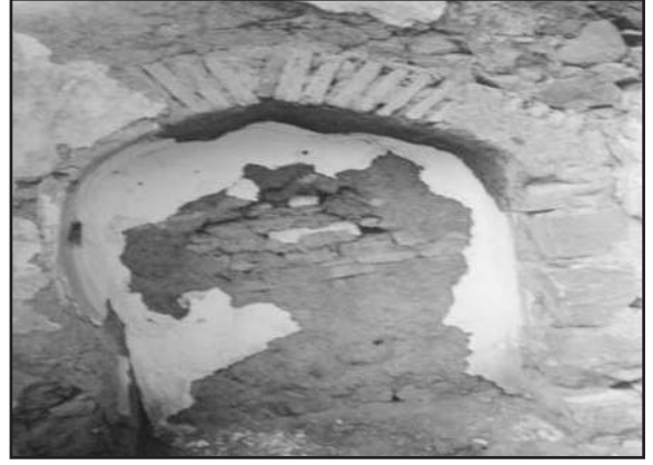
Resim 4: Siverek'te ak topraktan yapılmış sıva artıkları
