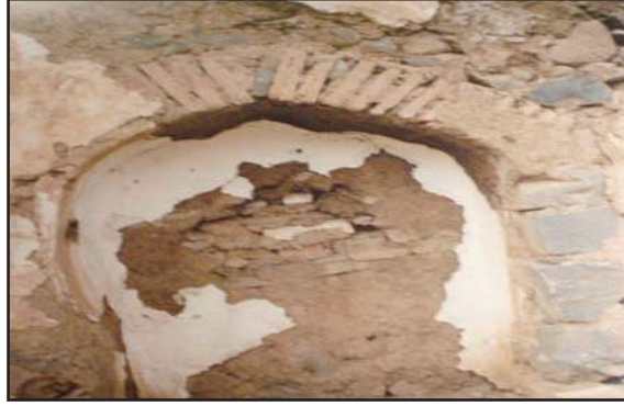
Sayfa 49 Resim 4: Siverek'te ak topraktan yapılmış siva artıkları
